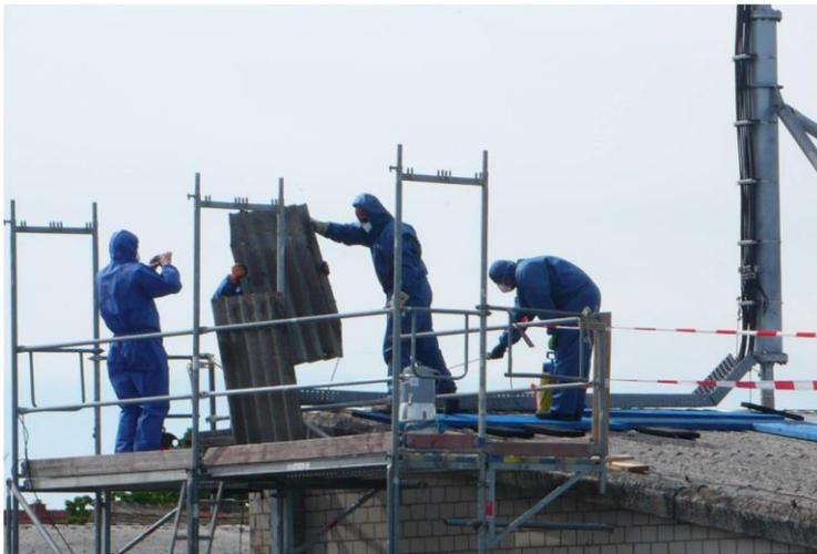
Sie kamen in Schutzanzügen. Angetan mit Atemmaske bereinigten sie einen rechtswidrigen Zustand, für den Raiffeisen und das Mobilfunk-unternehmen O<sub>2</sub> verantwortlich waren: Die Arbeiter, die den asbesthaltigen Untergrund des Mobilfunkmastes auf dem Dach von Raiffeisen in Flomborn beseitigten
